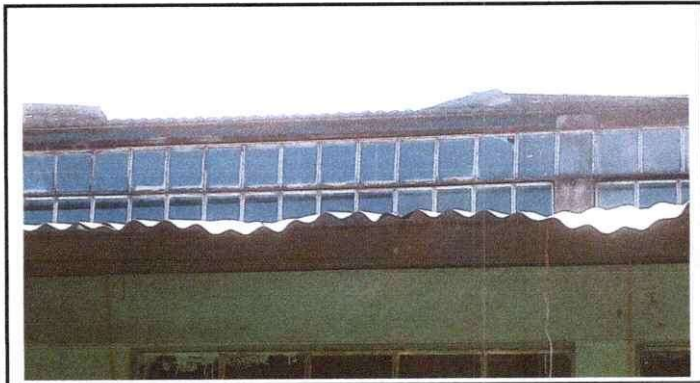
Foto 3: Cambio de techo
