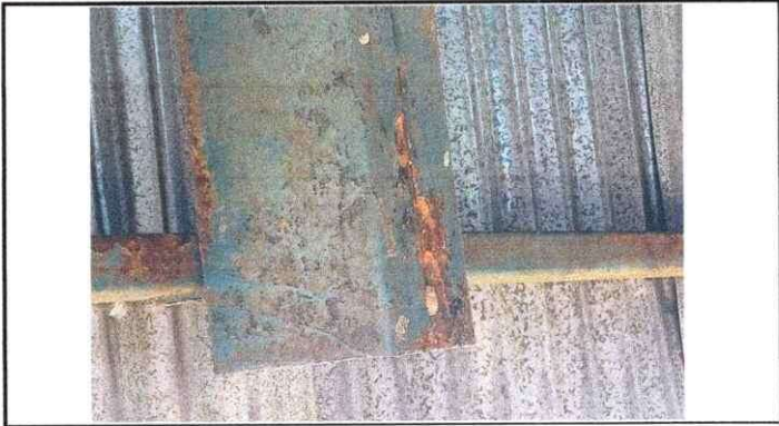
Foto1: Cambio de costaneras y tijeras de metal.
