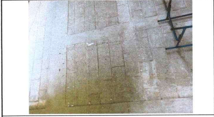
Foto 2: Pintada de paredes.
