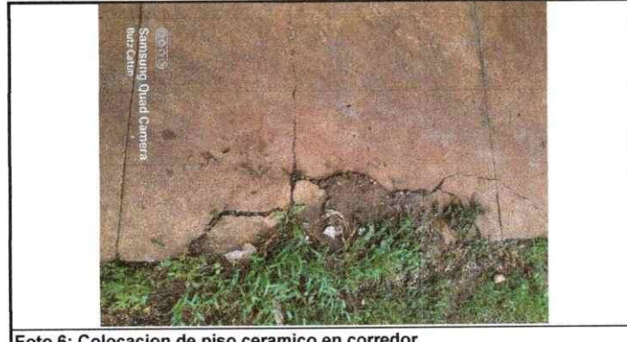
Foto 6: Colocacion de piso ceramico en corredor
